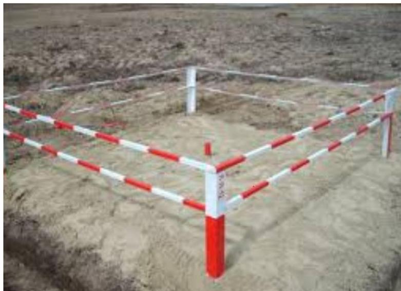
**Рисунок 6. Закладка пункта полигонометрии**
